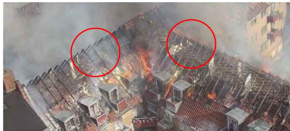
Figur 22 Hovedstadens Beredskab – Droneoptagelse - DJI_0070 (45 sekunder) Markering af 2 skillevægge i spidsloft.
